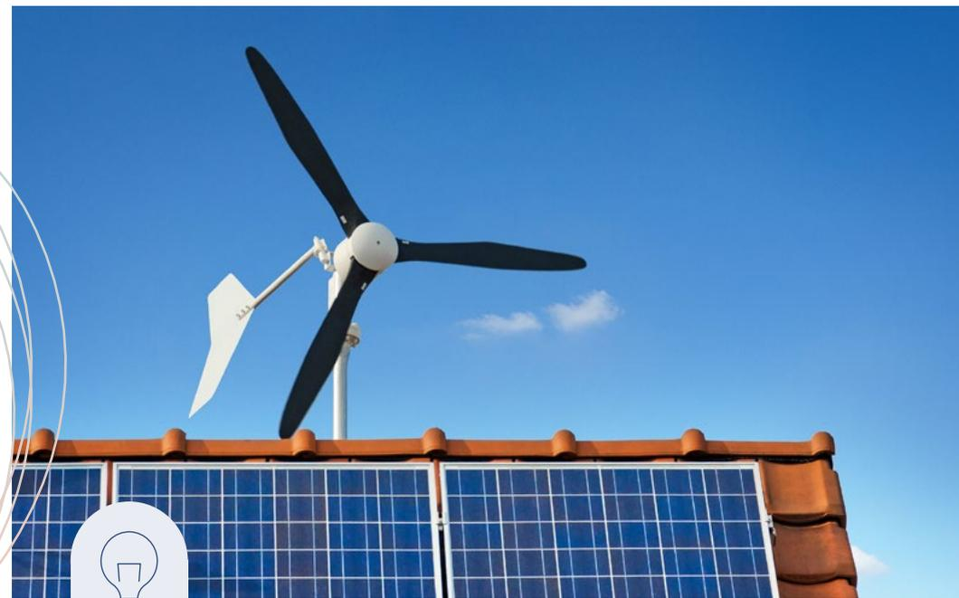
On parle de production d'électricité verte lorsque le consommateur produit sa propre énergie grâce à des panneaux photovoltaïques ou des petites éoliennes. Cette électricité est ensuite utilisée pour sa propre consommation. Dans le cas où la production dépasse la consommation, ce surplus d'énergie peut être revendu aux fournisseurs et réinjecté dans le réseau commun.
