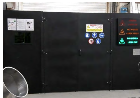
Pour l'occasion, une cabine entière a été installée.
